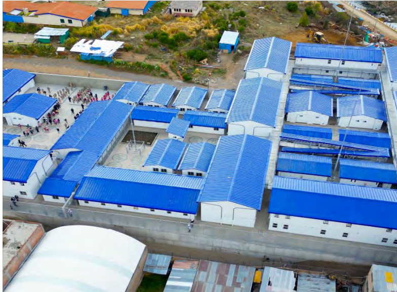
IMAGEN N° 02: Construcción de la I.E. La Victoria de Ayacucho avance físico de 10.1%.
