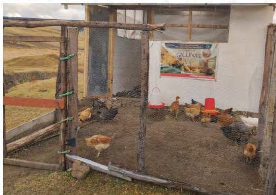
Instalación de Módulos de galpón de gallinas
