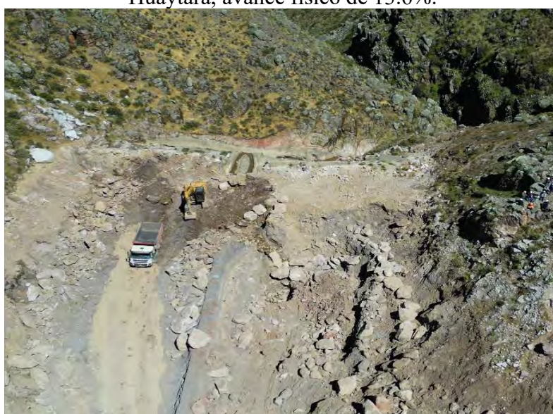
IMAGEN N° 04: Piedra Hermosa en el Distrito de Huaytará, avance físico de 13.6%.
